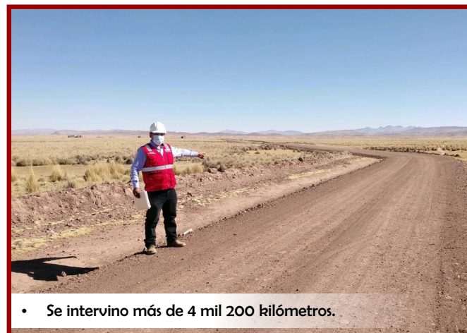
• Maquinarias con que se realizan los trabajos.
